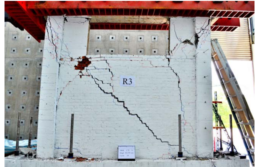
側位移比1.75%，短柱剪力裂縫快速發展且寬度加大
